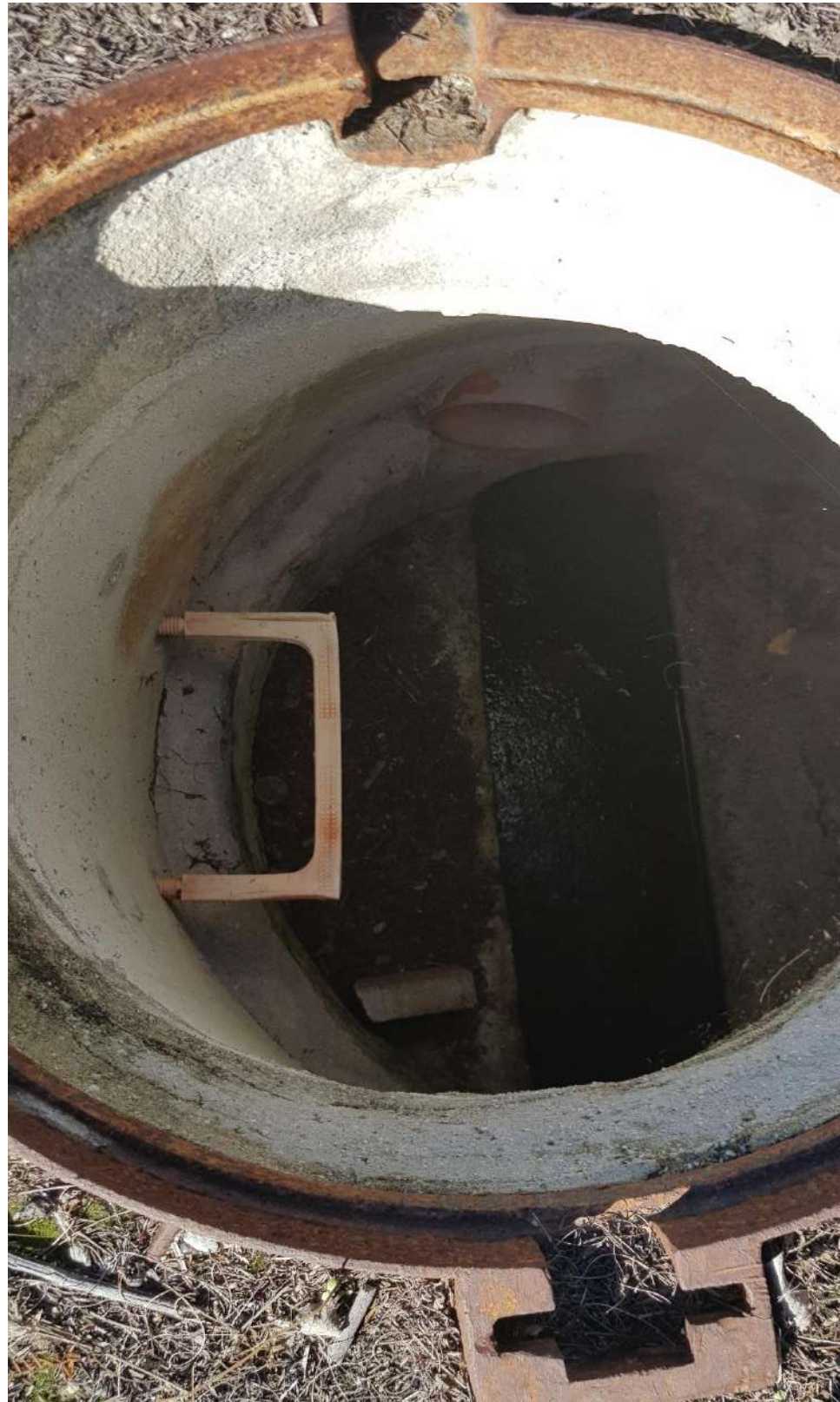
Fotografía nº8A (Detalle zona pozo)
