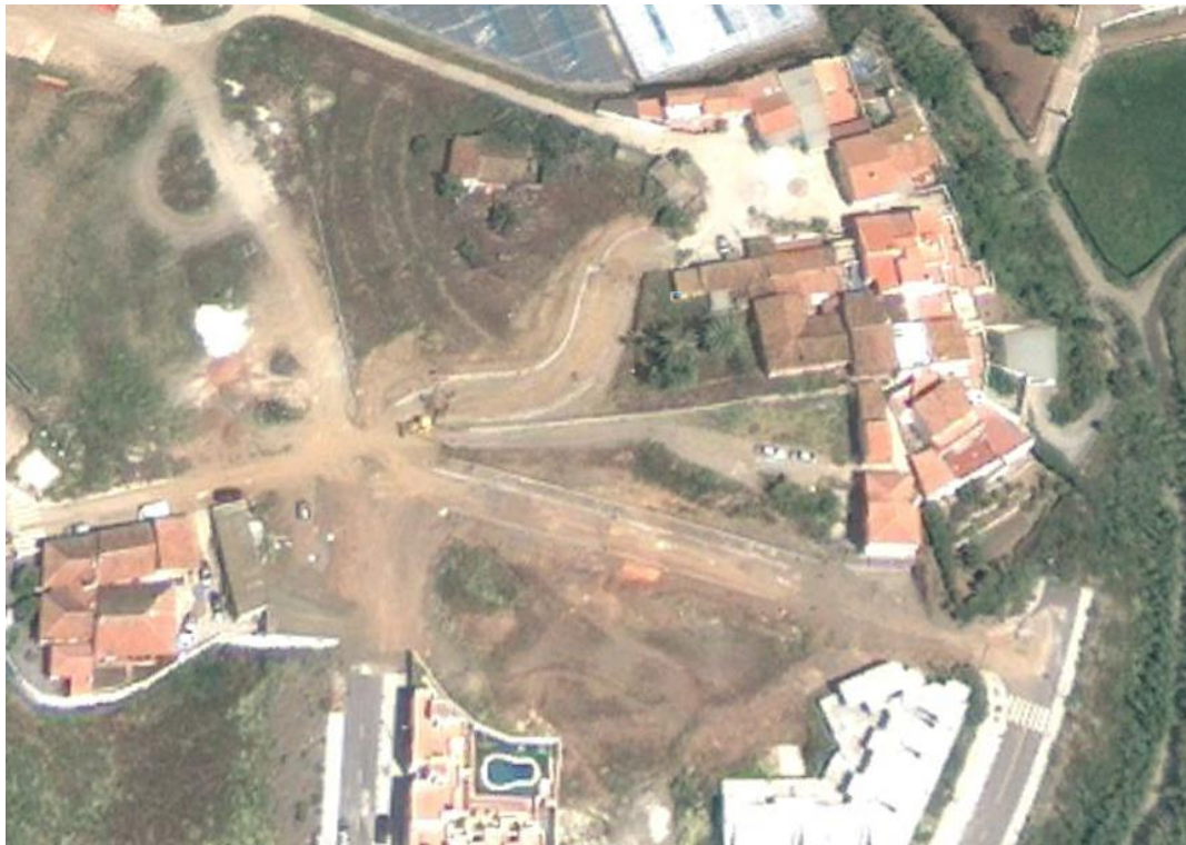
Fotografía aérea 2009, donde se ve la ejecución del vial del Plan Parcial que conecta con el vial exterior
