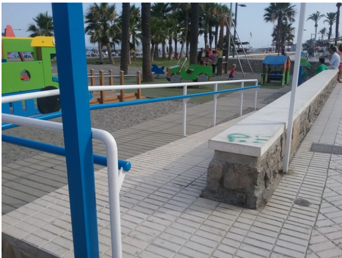
Rampa de acceso
