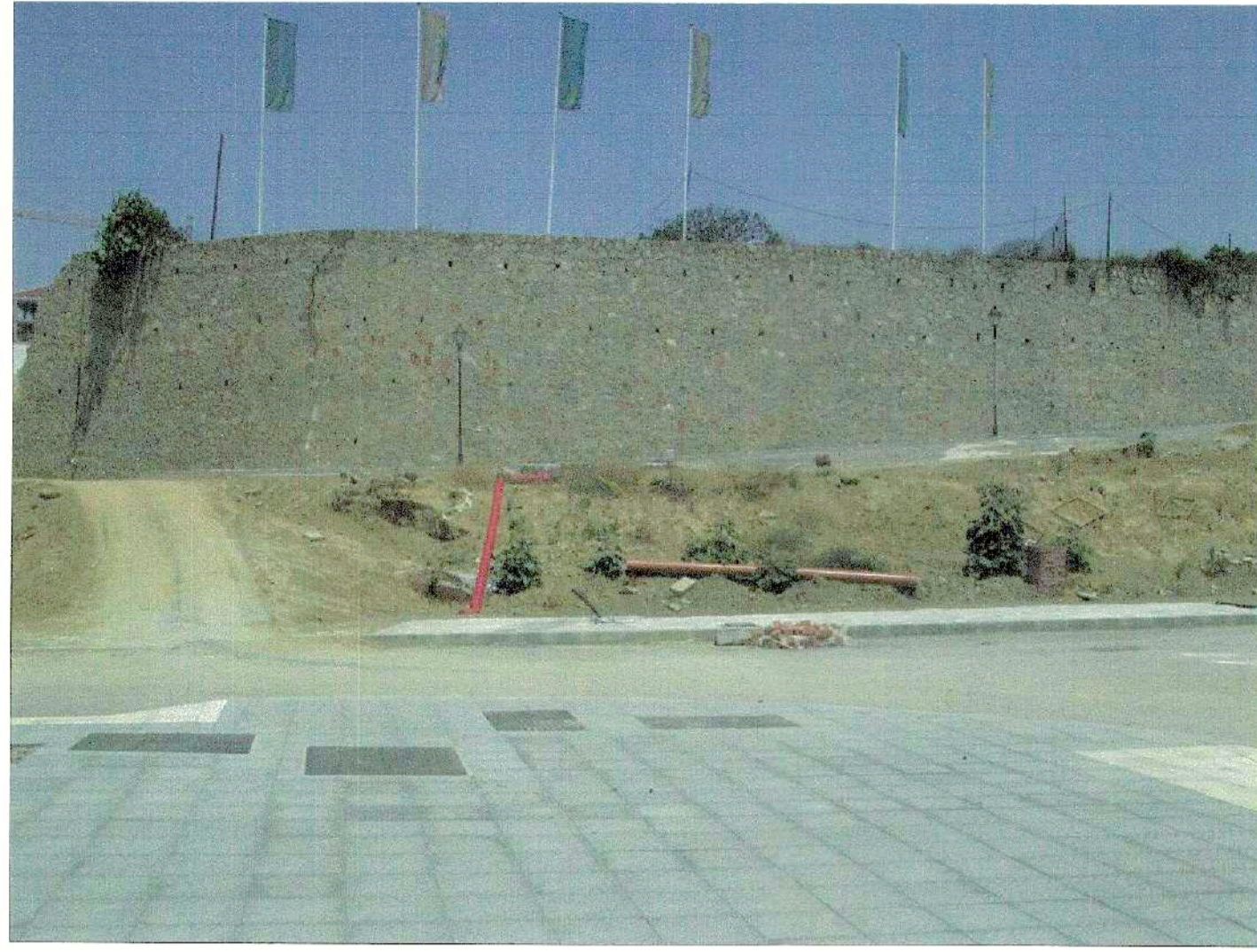
Fotografía nº 1. - Vista principal del muro grande.
