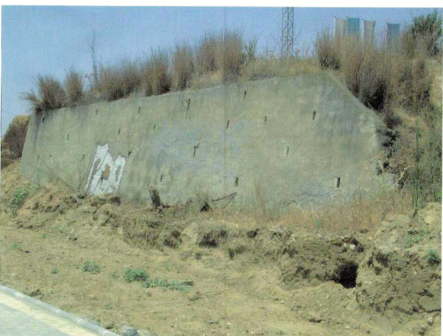
Fotografía nº 8. - Fotografía tomada desde la parte derecha del muro.
