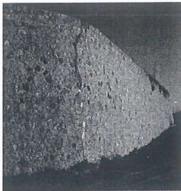
Vista central (ZE) MURO (ESTADO ACTUAL)
