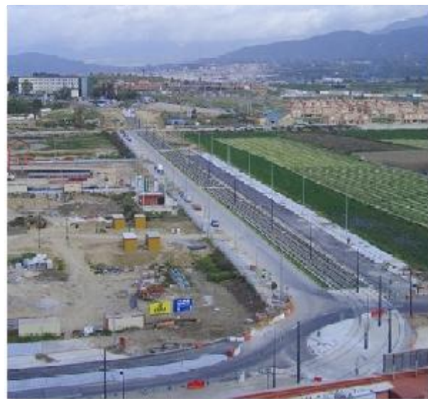
Vista aérea de la avenida Sevilla y el Hospital Comarcal (2006)
