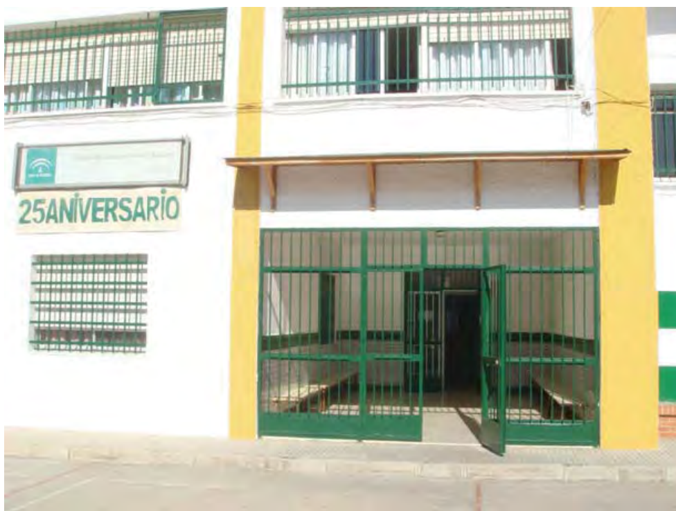
MME-022 Colegio Andalucía (Segundo Edificio)
