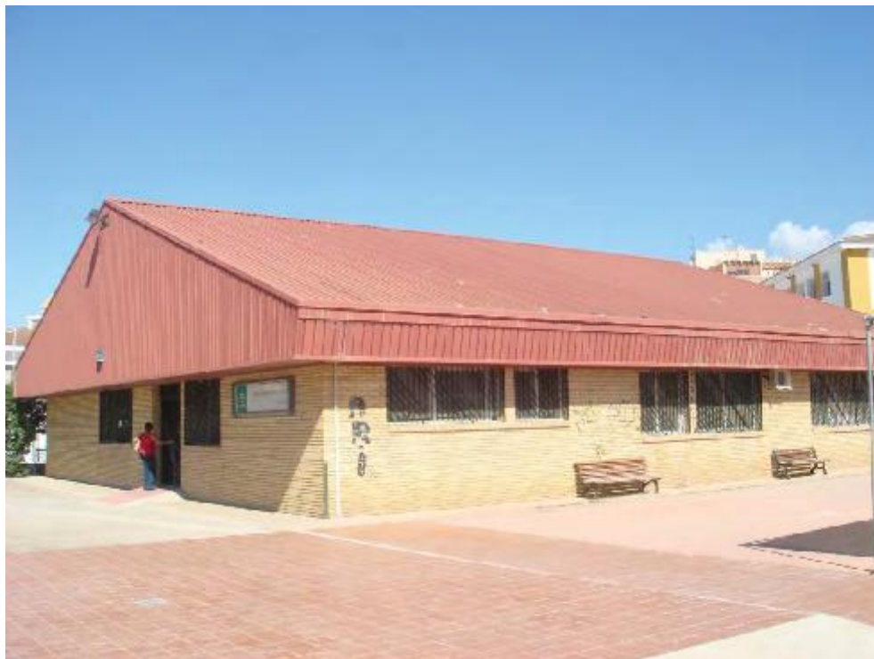
Foto del tejado para posible ubicación de paneles fotovoltaicos
