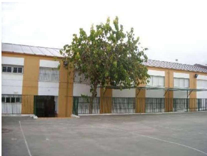
Foto cubierta Colegio " Augusto Bellido "
