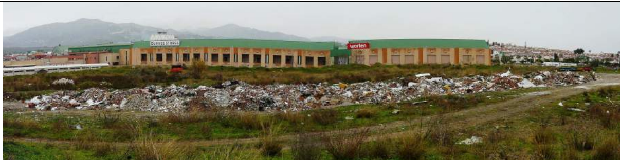
VISTA PARCIAL DE LA ESCOMBRERA DESDE EL NOROESTE
