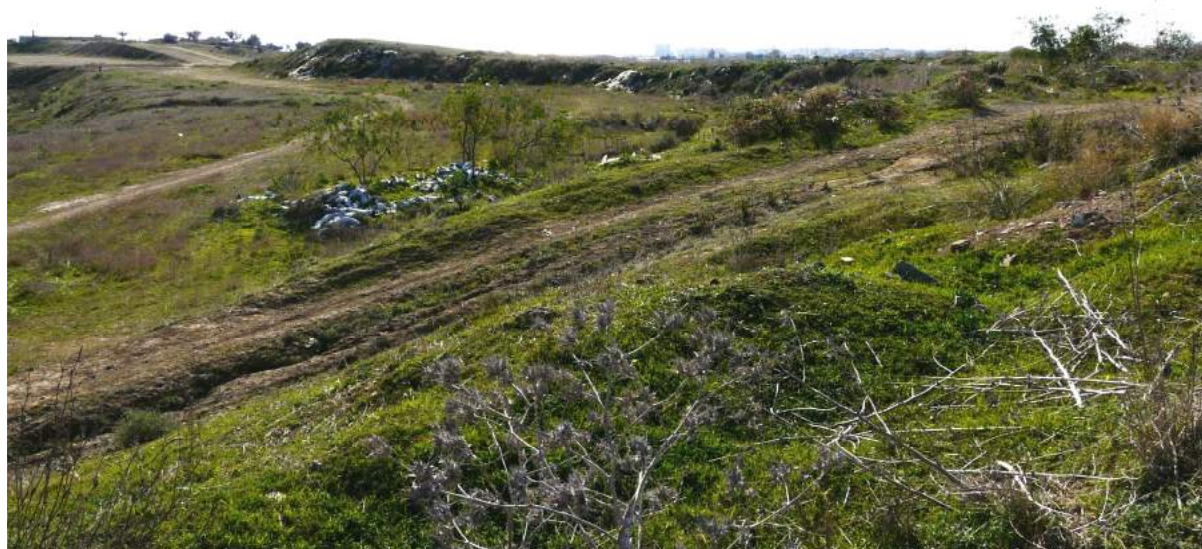
VISTA PARCIAL DE LA ESCOMBRERA DESDE EL NORESTE
