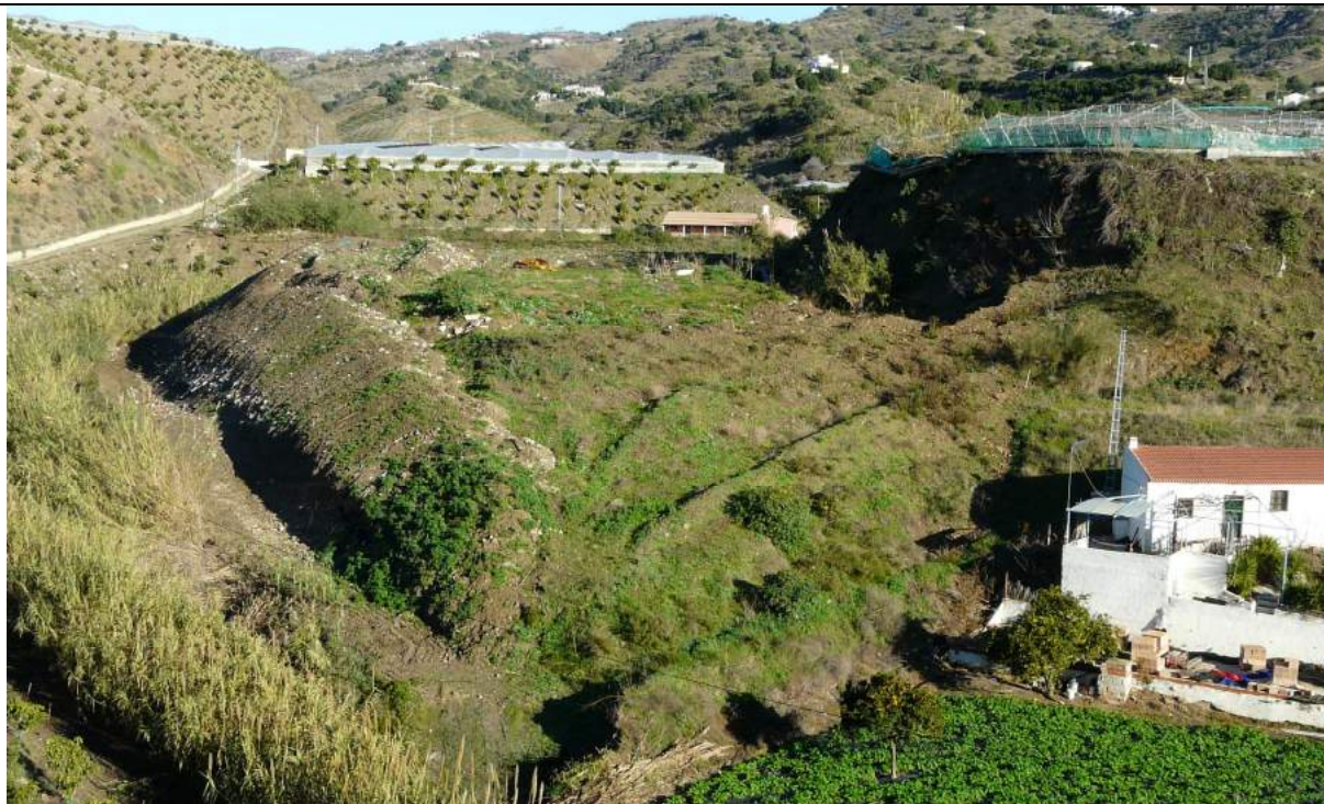
VISTA DE LA ESCOMBRERA DESDE EL NÚCLEO DE ÍBEROS
