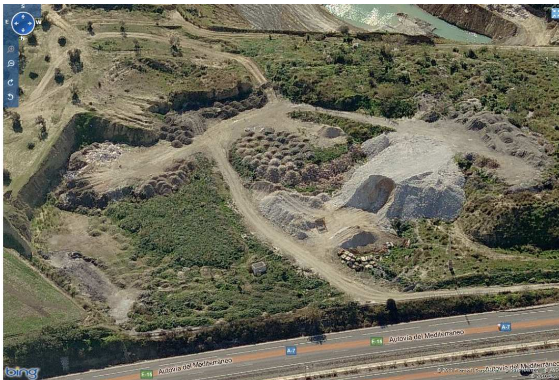
VISTA AÉREA OBLICUA DE LA ESCOMBRERA DESDE EL NORTE
