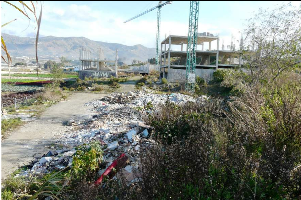
VISTA GENERAL DE LA ESCOMBRERA DESDE EL OESTE
