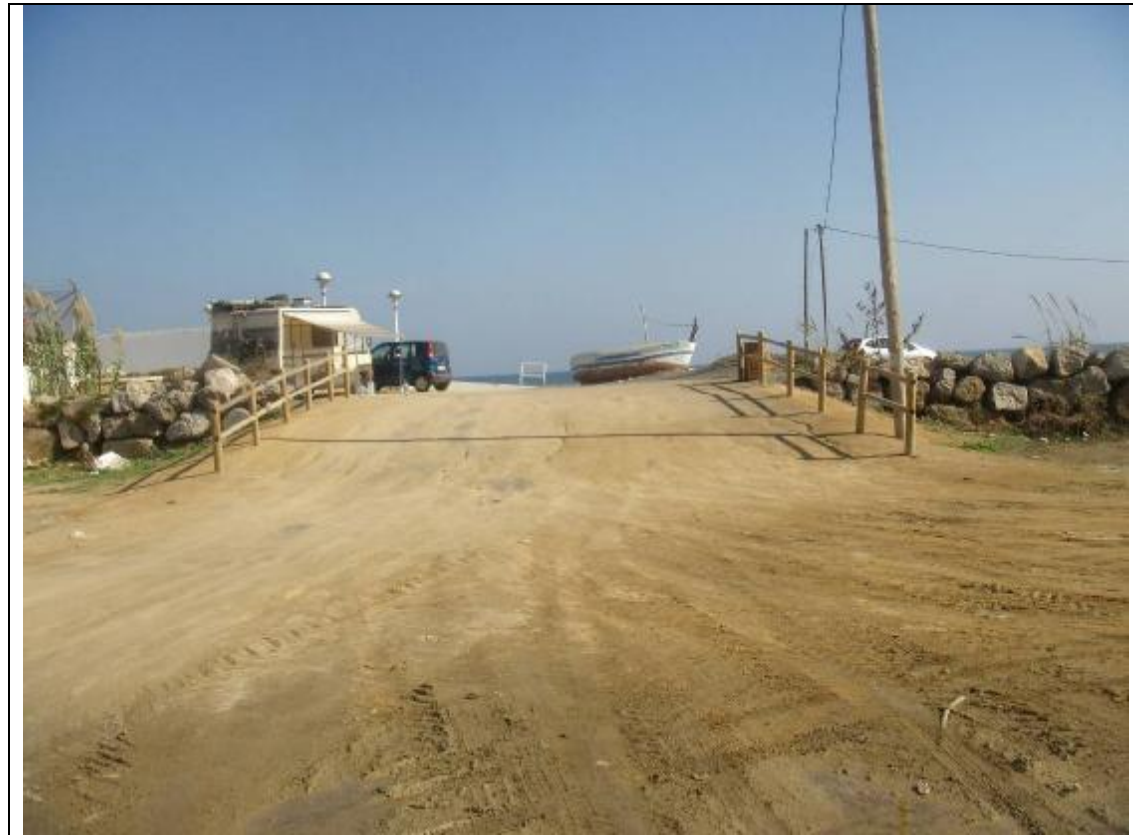
Fotografía 21 – discurriendo junto a los edificios llegamos hasta esta rampa que nos posibilita acceder a la zona peatonal final del paseo marítimo.
