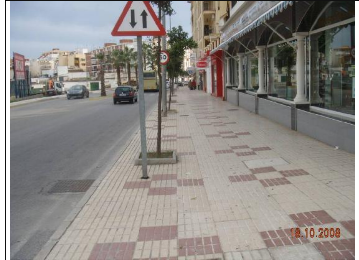
Fotografía 15 – Este es el último tramo de acera existente antes de llegar al entorno al que accede el ramal Vélez-Torre del Mar del desdoblamiento realizado entre estas dos poblaciones. La anchura disponible es algo más escasa, pero suficiente.
