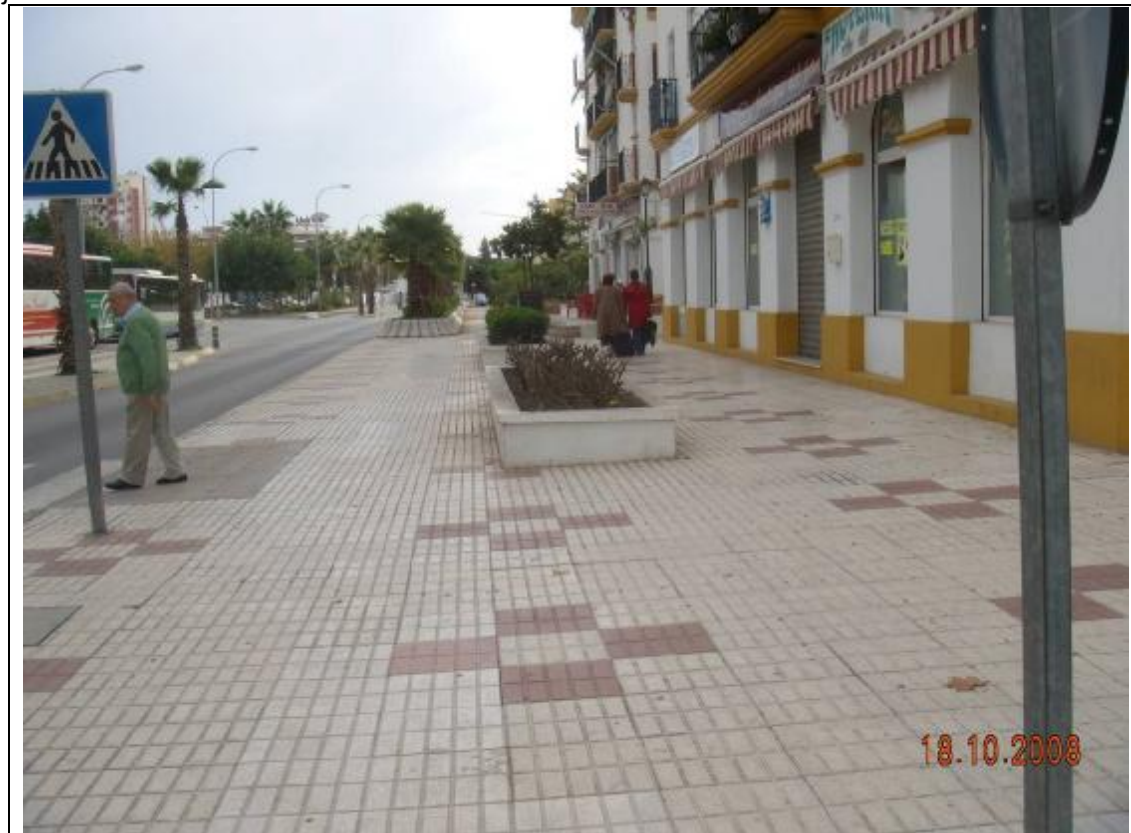
Fotografía 10 – La amplitud de la acera en las zonas que no hay aparcamientos es más que suficiente para implantar nuestro carril.
