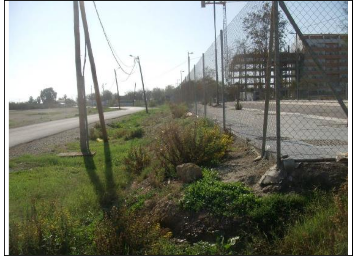
Fotografía 19 – Llegamos al final del vial construido. Los comentarios de las dos anteriores fotografías son exactamente reproducibles en este caso.
