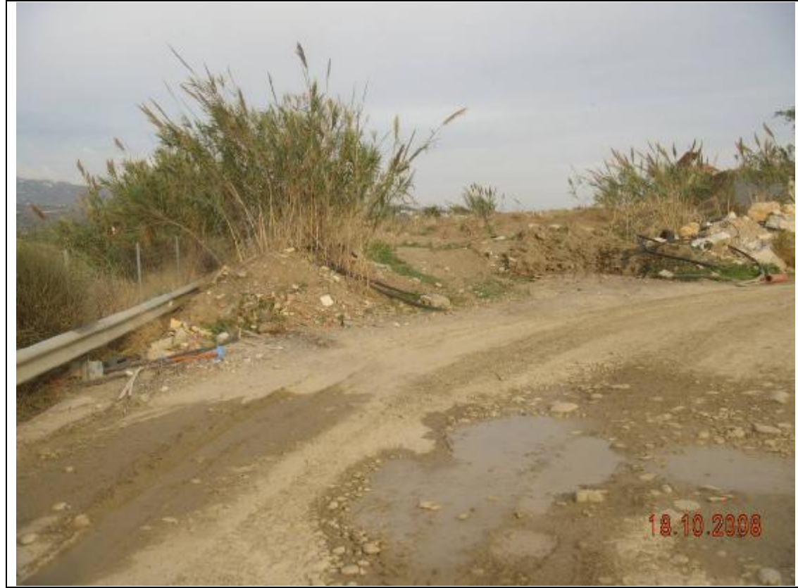
Fotografía 5 – Estamos entrando en un entorno en el que el carril desaparece por haberse utilizado este espacio para acopiar restos de vertedero.
