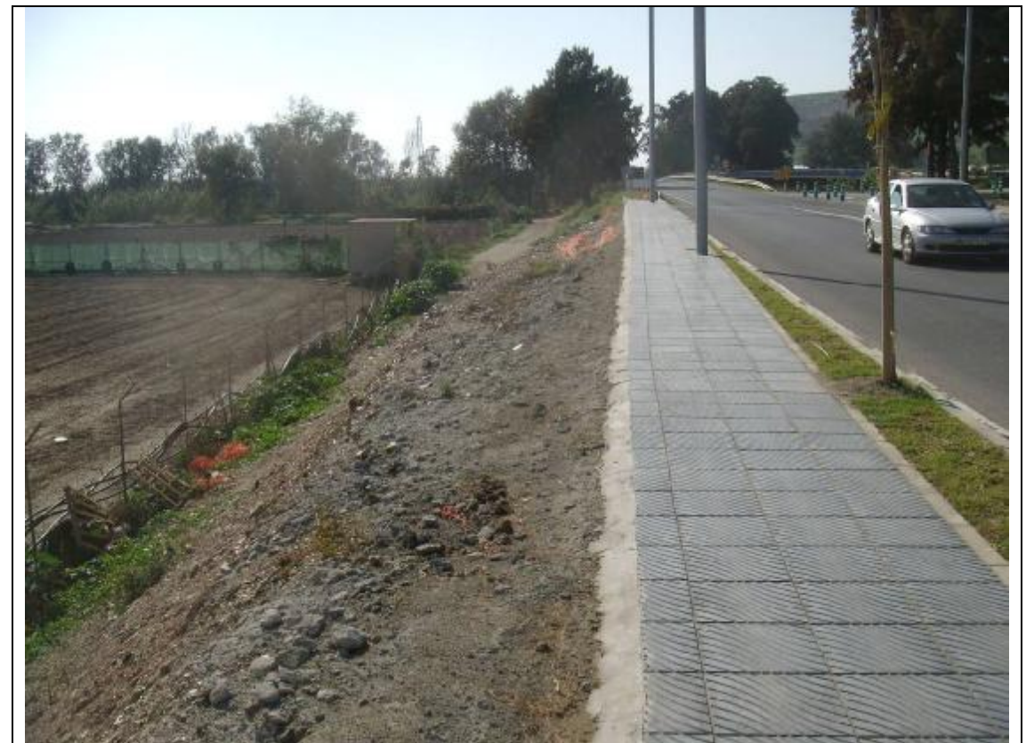
Fotografía 8 – Hemos ascendido al borde de la carretera, vemos en el centro de la imagen el carril mostrado en la anterior fotografía, que deberá continuar su trazado ocupando parte de la finca que vemos a nuestra izquierda.
