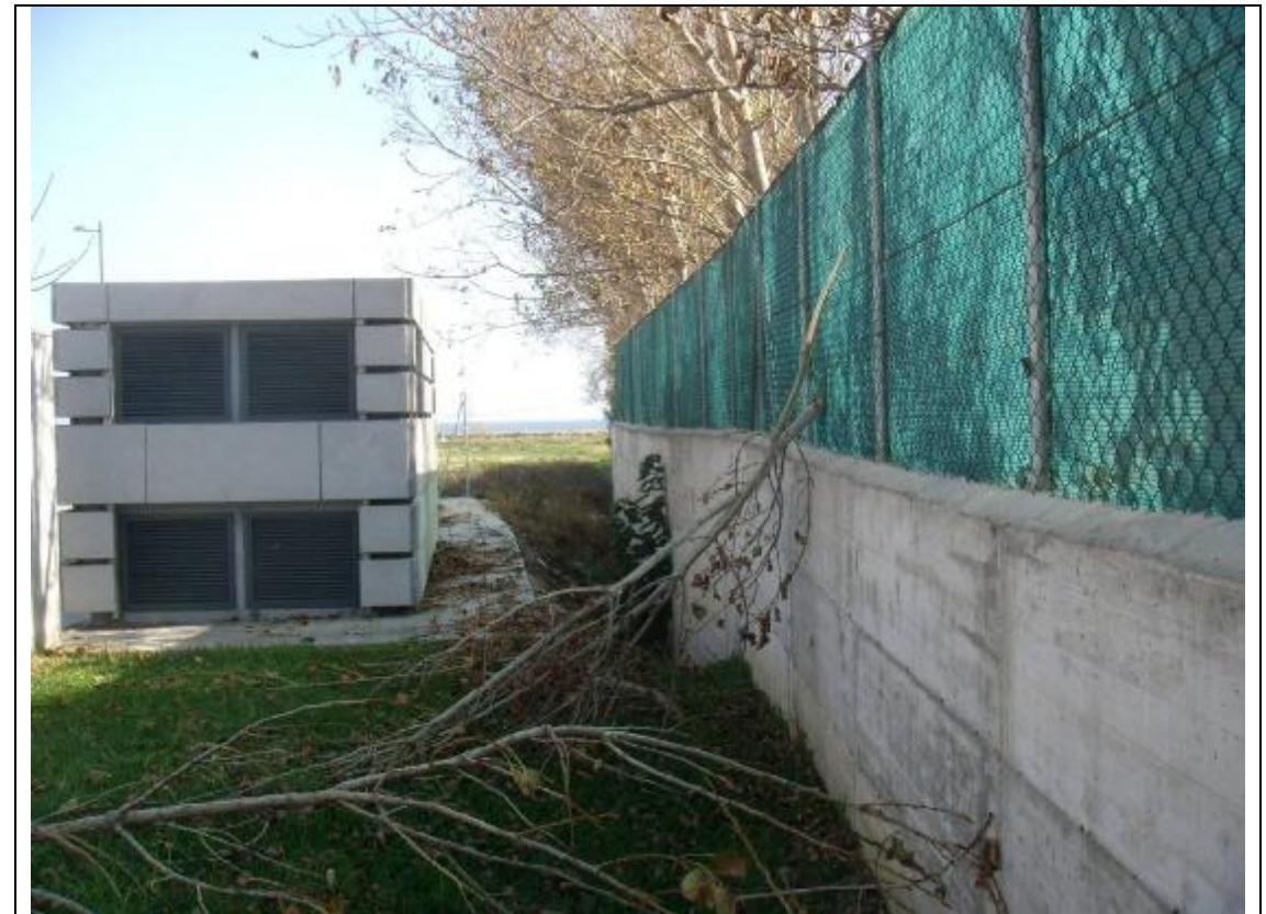
Fotografía 16 – Un paso justo, pero posible, entre el transformador y el cerramiento del camping.
