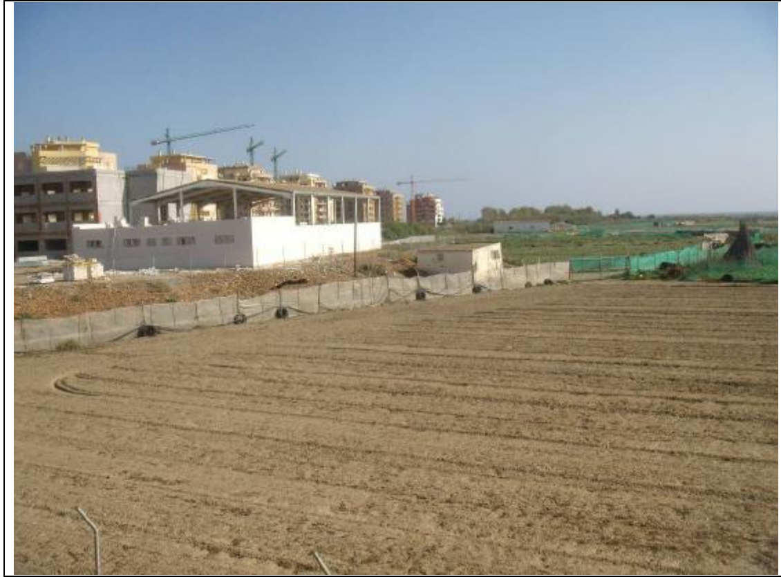
Fotografía 9 – Nuestro carril deberá seguir bordeando la misma finca, a la que nos referíamos en la fotografía anterior, que ahora preside toda esta imagen. Detrás de la nave en construcción, llegaremos al borde de la zona verde por la que tendrá una adecuada continuidad el carril,
