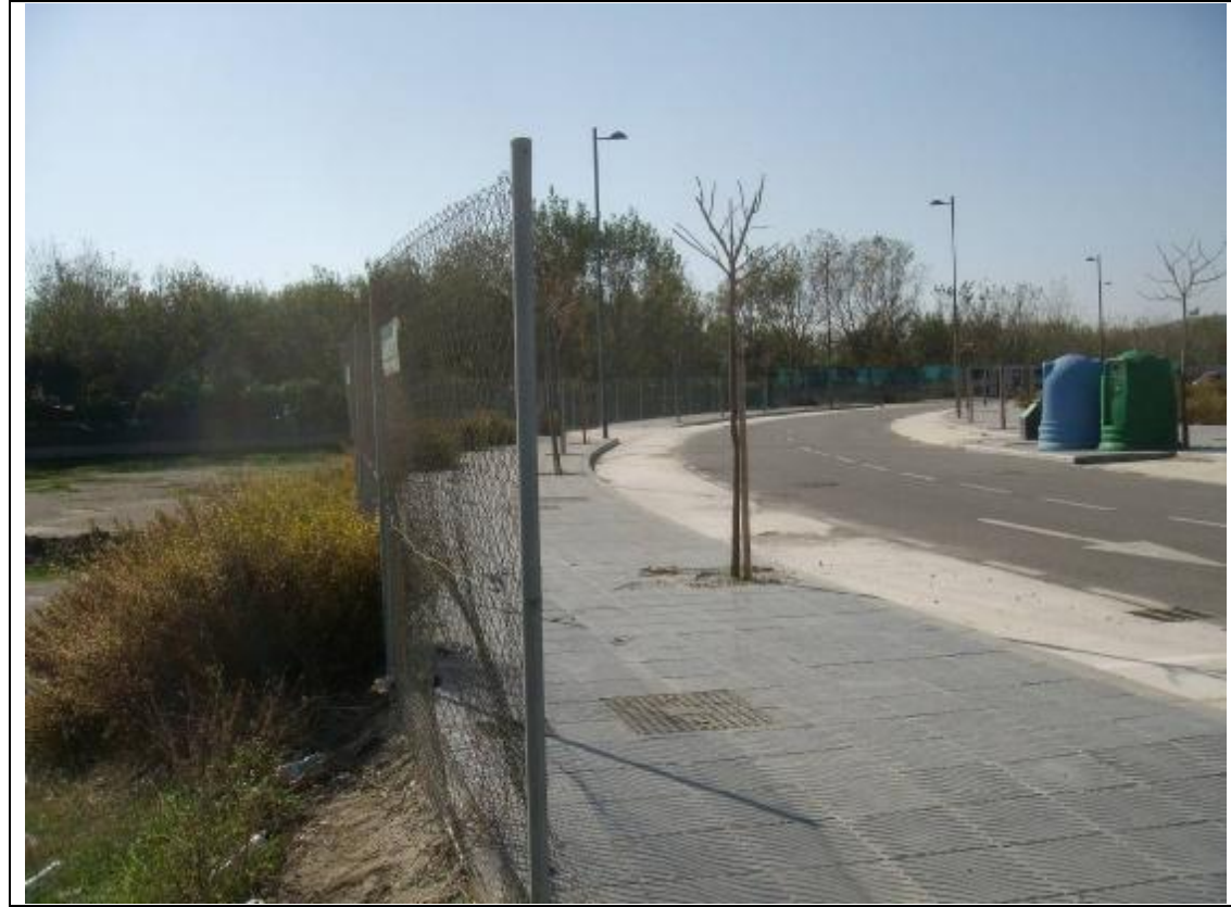
Fotografía 17 – El vial continua hacia la zona central de Torre del Mar. El carril de bicicletas se puede implantar en el límite exterior de la acera, u ocupando una parte de esta.
