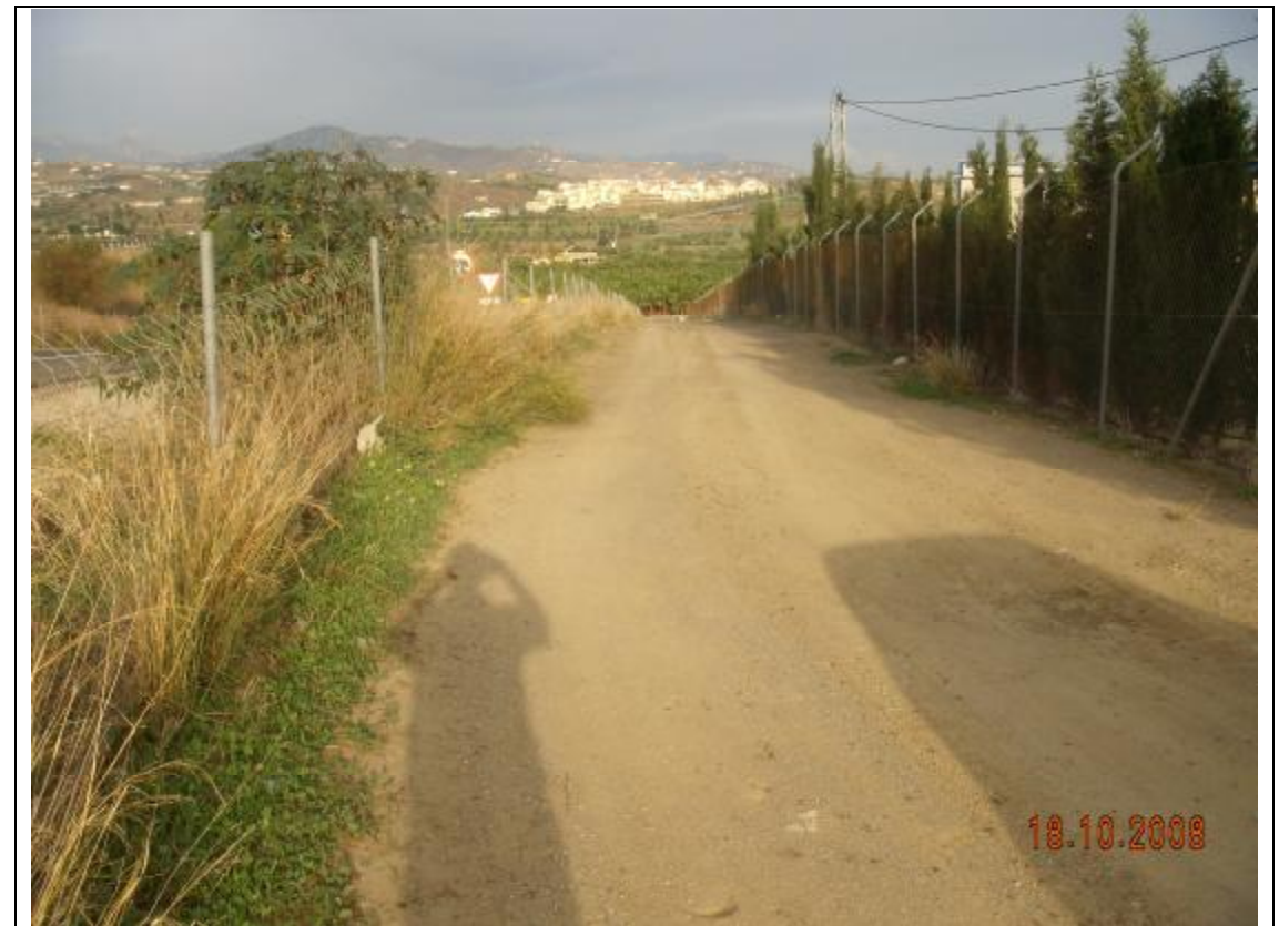
Fotografía 12 – Giramos la cámara 180º y, con más claridad, vemos como el carril actual desciende hacia el Camino de Torrox.
