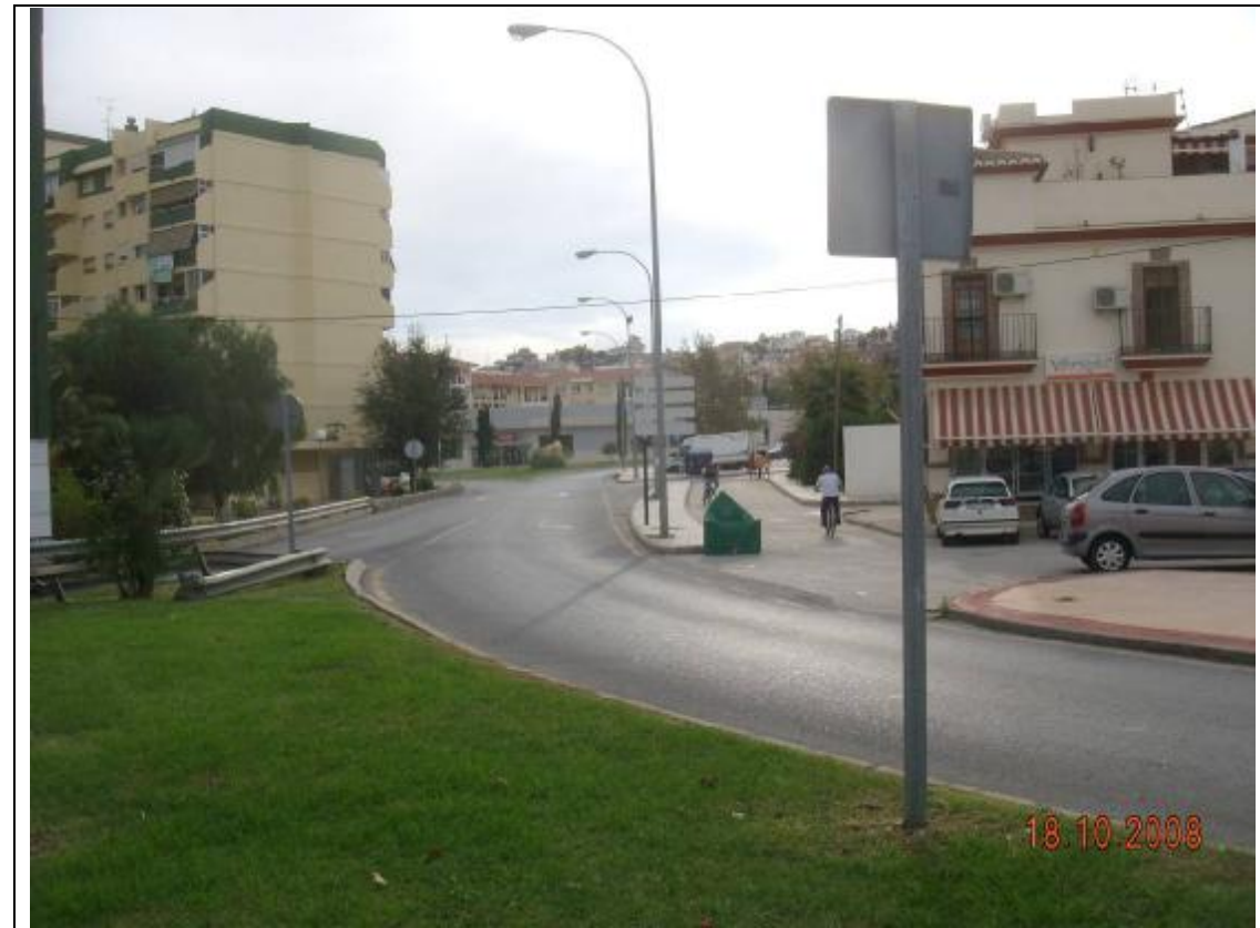
Fotografía 17 – la isleta que veíamos en la fotografía anterior se sitúa ahora en el centro de esta fotografía. El carril discurrirá ocupando parte de la bolsa de aparcamiento, que vemos al fondo, y la vía de servicio que no resulta imprescindible.
