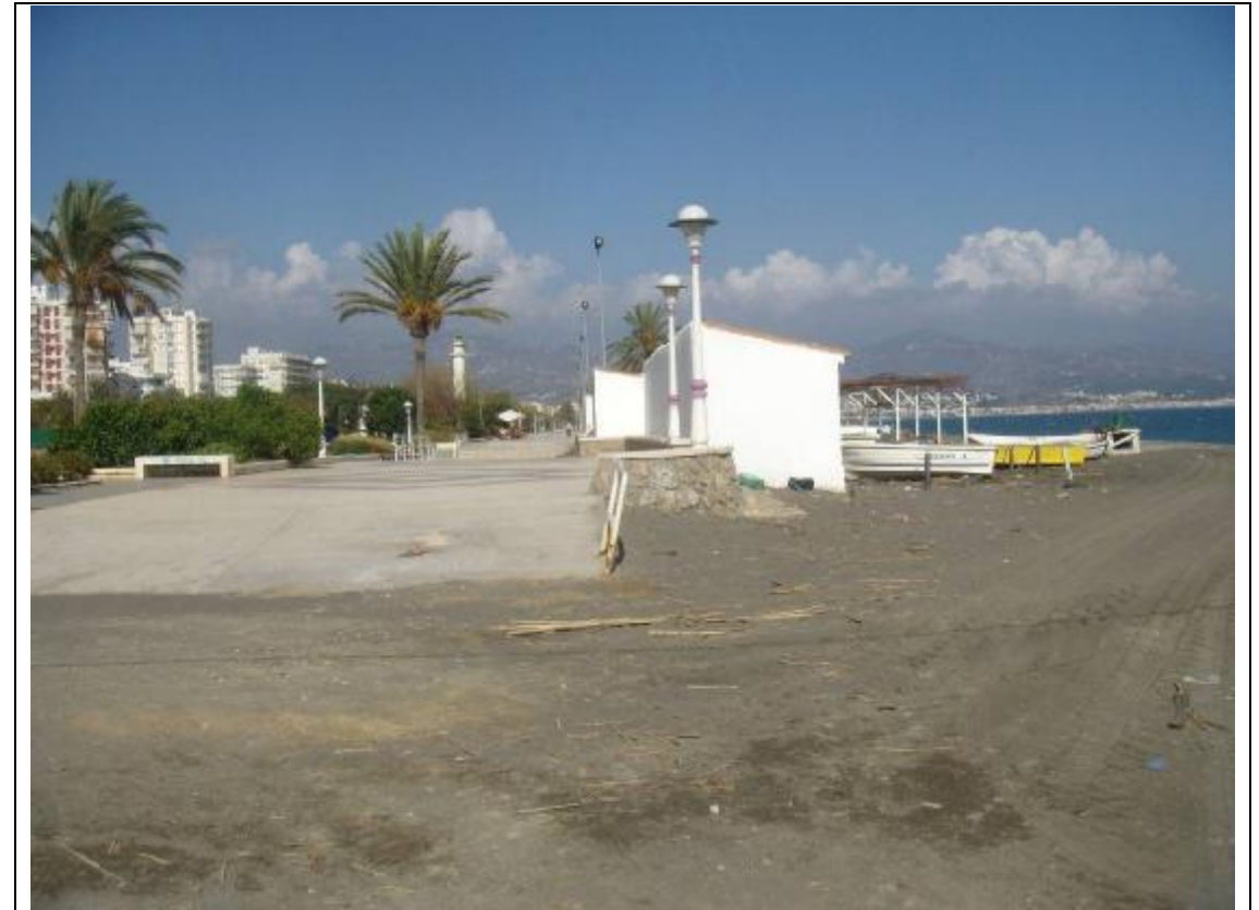
Fotografía 22 – El carril longitudinal que deberá discurrir por el paseo marítimo llega hasta este lugar, y en este entorno pretendemos conectar con él.
