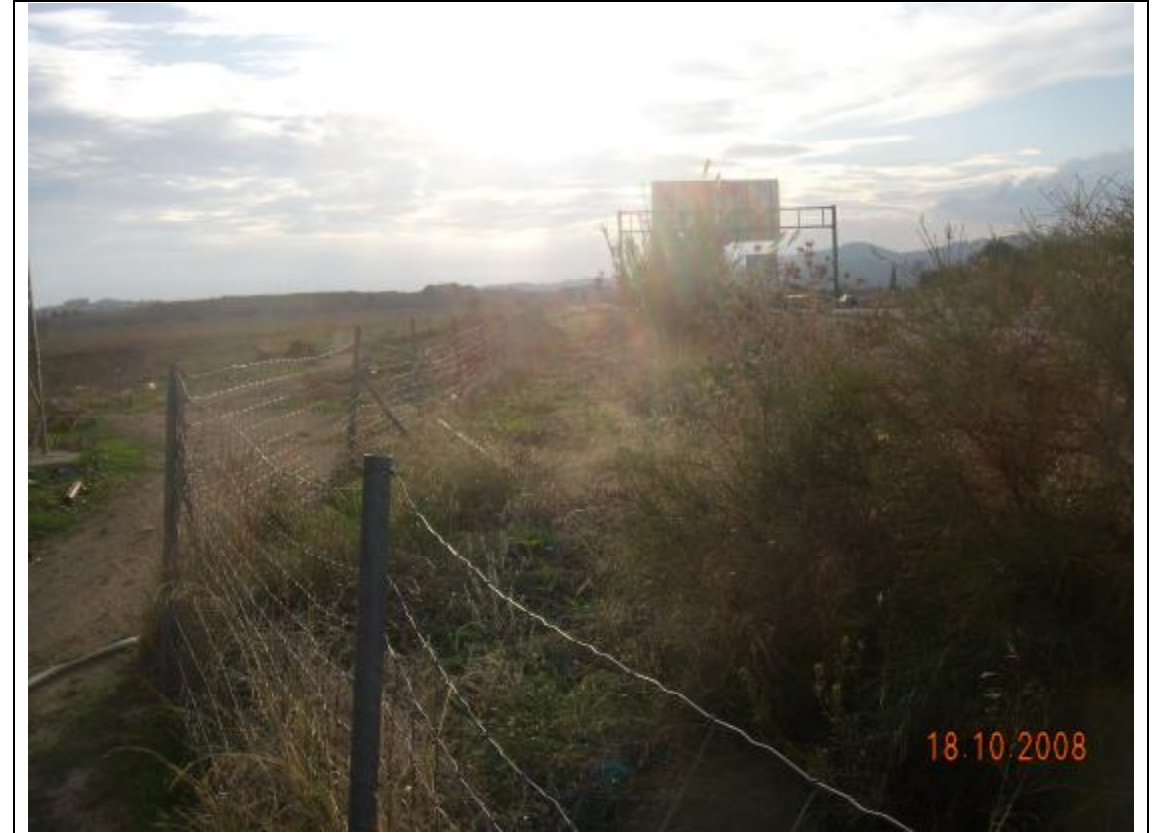
Fotografía 11 – Más adelante, mirando hacia poniente, vemos el límite de ocupación de la autovía. Por el que implantaremos nuestro carril sin problemas.
