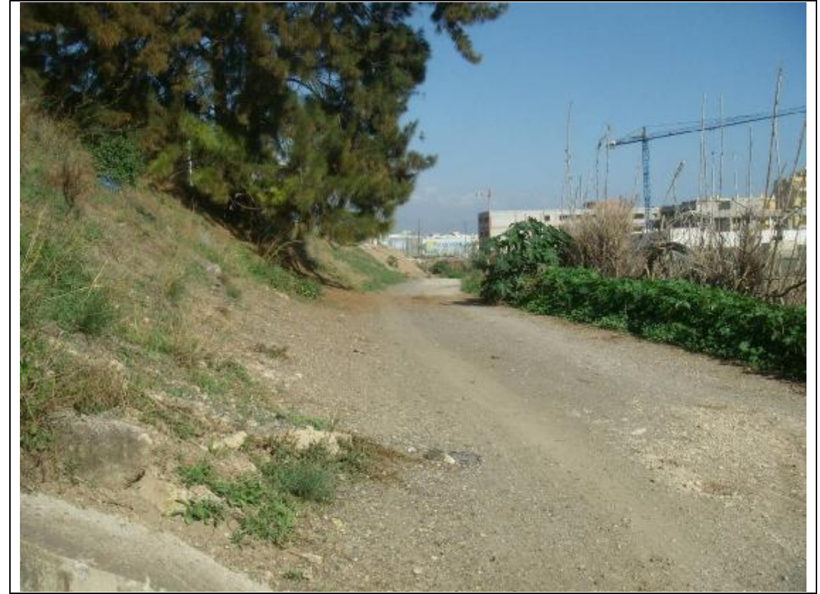
Fotografía 7 – Superado el puente nos podemos dirigir hacia el este por el carril existente al pie del terraplén de la CN-340.
