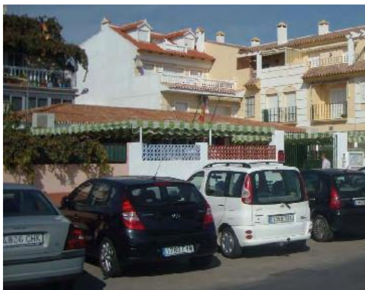
Cubierta de la Guardería de Torre del MAR
