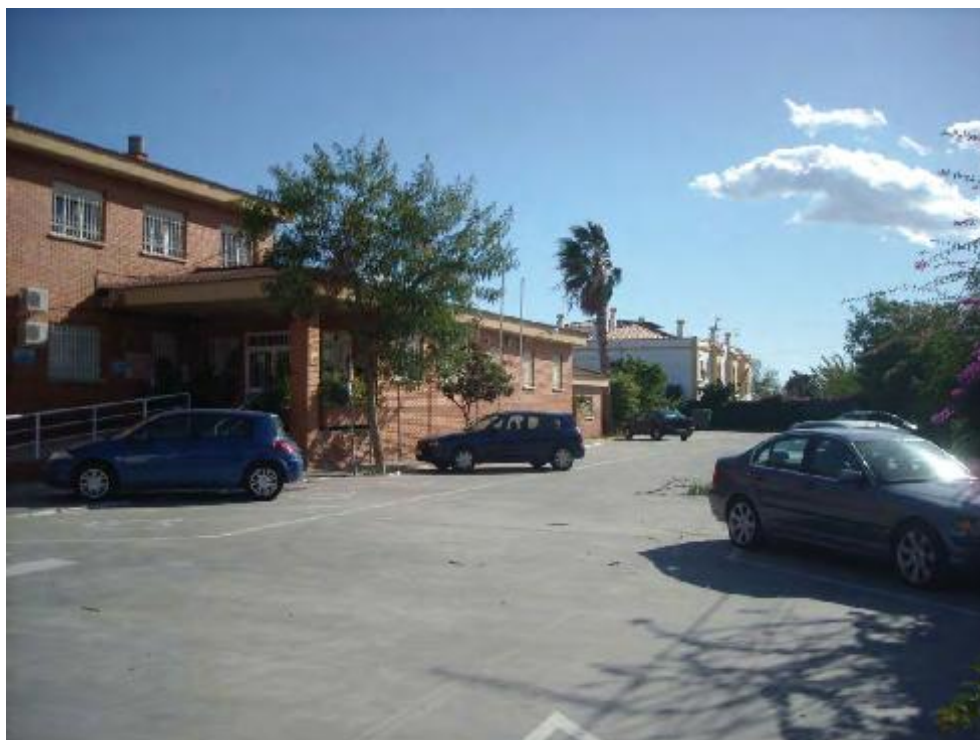
Foto cubierta Colegio" Axarquía"
